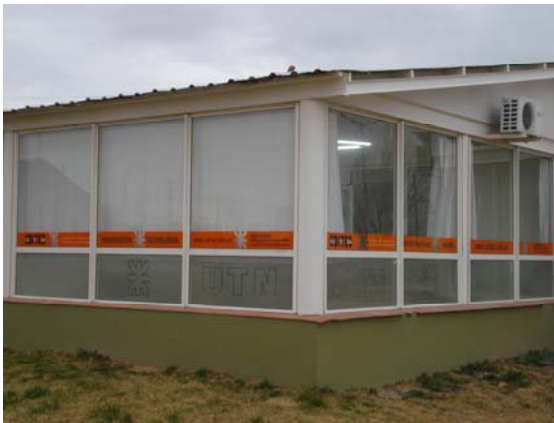
Vista exterior oficina UDITEC
