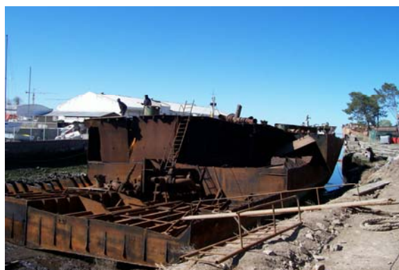
Vista desguace de embarcación “Cabo Verde”
